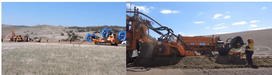
1.2.5 pav. Elektros kabelio klojimas 25 .
