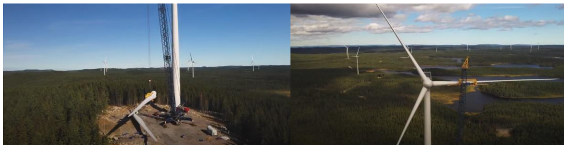
1.2.4 pav. Rotoriaus menčių montavimas 24 .
